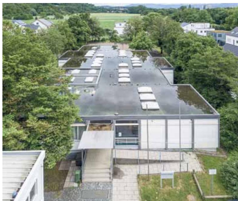
In der Ötlinger Halde soll das Gebäude der Grundschule einer Wohnbebauung weichen. Foto: Carsten Riedel
