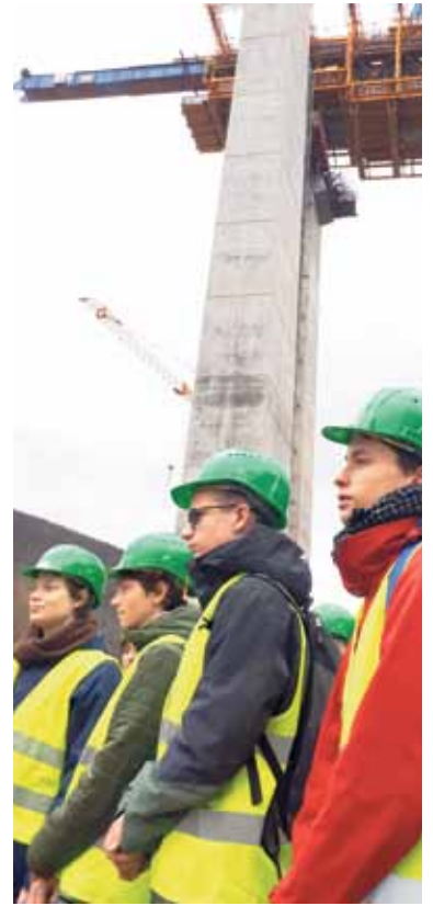
Neben dem mächtigen Pfeiler der Filstalbrücke bei Wiesensteig erhalten die Schüler Einblick in die Brückenstatik.
