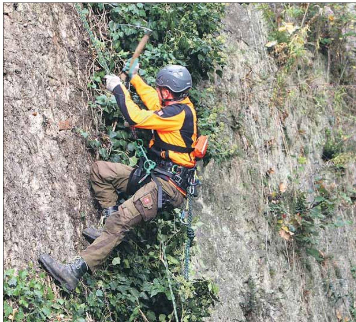
Die Sanierungsarbeiten an der Bastion erforderten Kletterkünste im dichten Grün.
