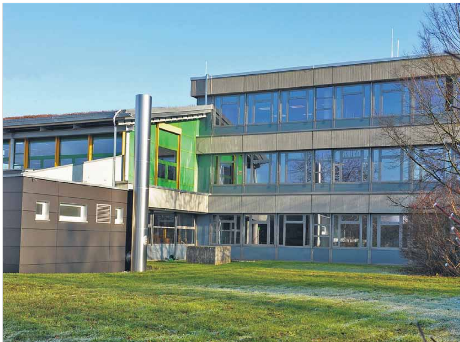
Am Kirchheimer Schlossgymnasium, das vor einigen Jahren um den zweiten Stock erweitert wurde, wird im kommenden Jahr weiter in Bildung investiert. – Inklusiver Brandschutz. Foto: Markus Brändli
