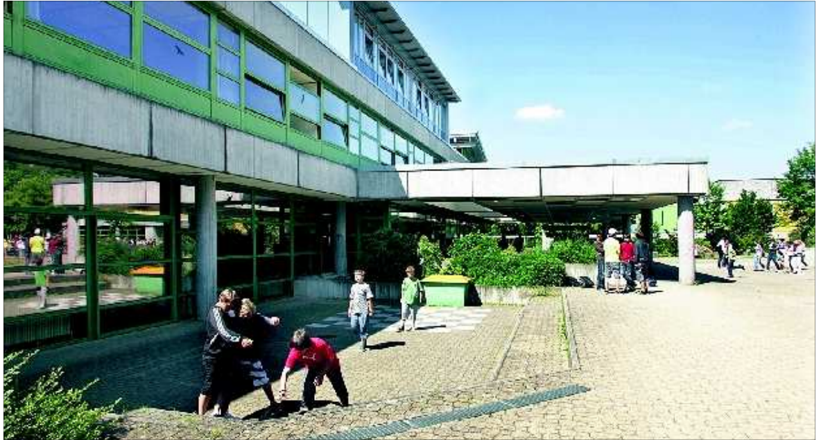
Das Bild zeigt im zweiten Stock die bereits vorhandenen neuen Klassenzimmer des Schlossgymnasiums. Links daneben sollen nun acht weitere Klassenzimmer entstehen. Davor gibt es ein neues Treppenturm, das direkt im Anschluss an das Vordach seinen Eingang bekommt. Es ist fünf Meter vom eigentlichen Gebäude entfernt und wird mit diesem über zwei Stege verbunden. Foto: Jörg Bächle
